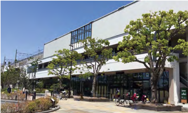
葛西臨海公園駅高架下ビル
